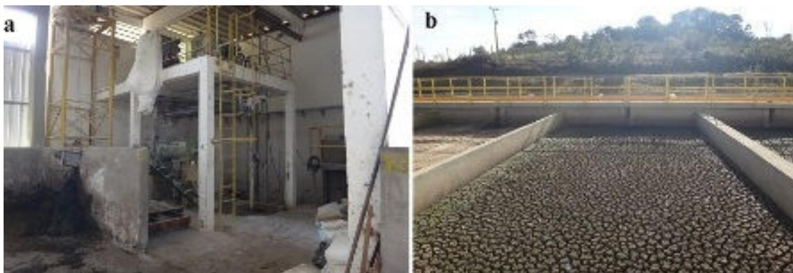
Figura 3 – Tratamento do lodo – a) Centrifuga; b) Leito de secagem de lodo
