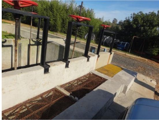
Figura 5 – Grades de ferro galvanizado
