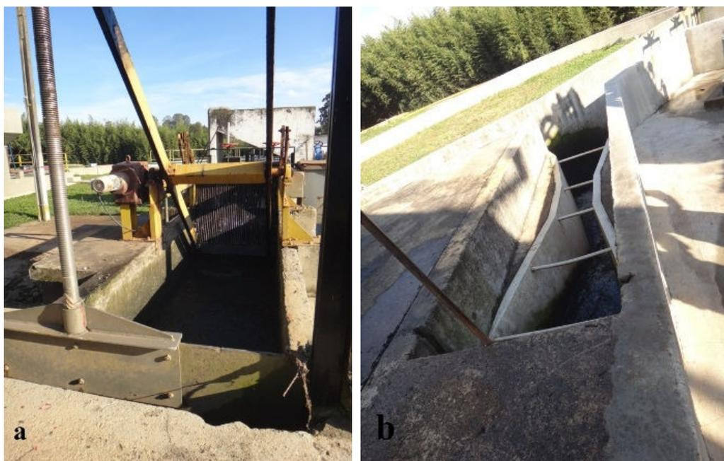
Figura 1 – Tratamento preliminar: a) gradeamento; b) Calha Parshall
